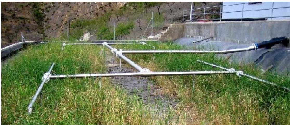
Figura 4: Pré-tratamento de esgotos brutos nos filtros de brita, uma forma especial de wetlands de fluxo vertical
