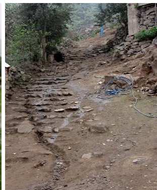
Figura 9: Aguas grises sobre calles de un asentamiento Fuente: H. Hoffmann
