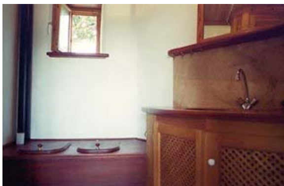
Figura 10 : Baño seco integrado en el cuarto de baño
