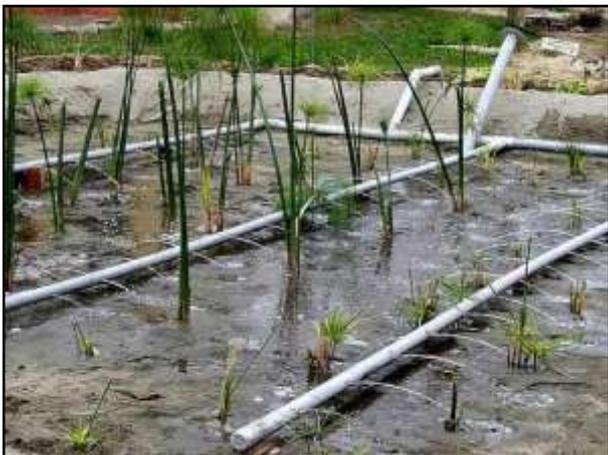
Figura 26. Humedal recién sembrado de flujo vertical (FV) durante el bombeo (Lima, Perú) para el tratamiento de las aguas grises. Toda la superficie es utilizada como área de entrada, la cual se recubre con grava (fuente: H. Hoffmann, 2008).
