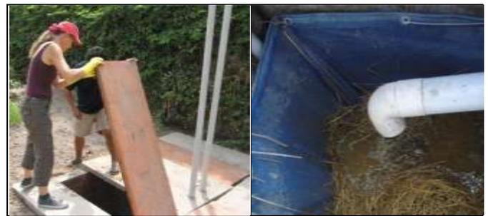
Figura 15a/b: Filtro de Compost en Lima, Perú, (a) sistema con doble cámara ventilada, (b) cesta en la etapa de llenado (fuentes H. Hoffmann, 2008)
