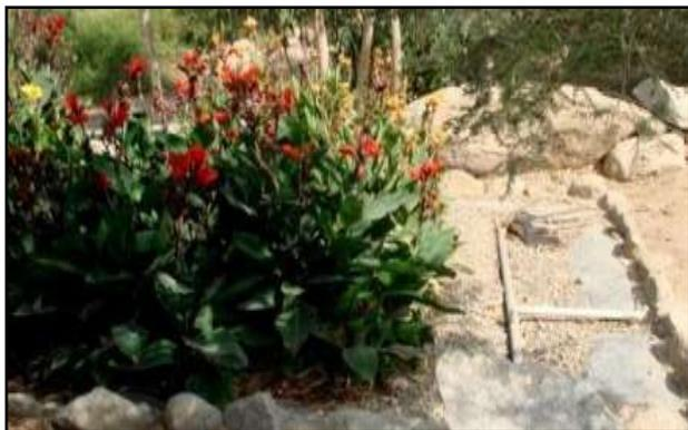
Figure 22. Humedal de flujo horizontal (HFH) para el tratamiento de aguas grises en Lima/Perú, área de entrada con grava y tubos de distribución (fuente: R. Miglio, 2009).
