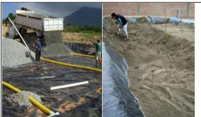
Figura 5 a/b. HHAA FSS (FV) para la reutilización de aguas residuales en (a) Brasil y (b) Perú. El revestimiento para la impermeabilización.
