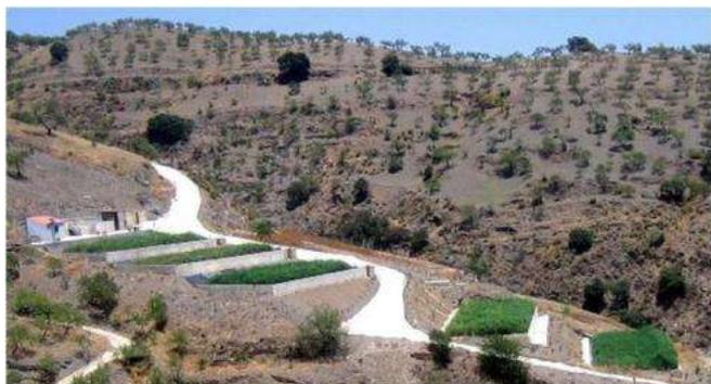
Figura 28. Sistema Francés de HAA de FSS: 3 filtros para el tratamiento primario y 2 filtros para el tratamiento secundario, Albondón, España (fuente: T. Burkardt AKUT, 2005)
