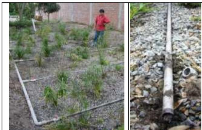
Figure 36 a/b: (a) Limpieza de la tubería de distribución, abriendo y cerrando las válvulas y las tapas durante la fase de bombeo, (b) tapa abierta de una tubería de distribución bloqueada (fuente: H. Hoffmann, 2009)
