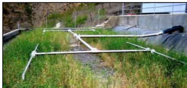
Figura 30. Detalles técnicos del tratamiento primario de aguas residuales crudas en el sistema francés de HAA de FSS: Albondón, España (fuente: T. Burkardt AKUT, 2007)
