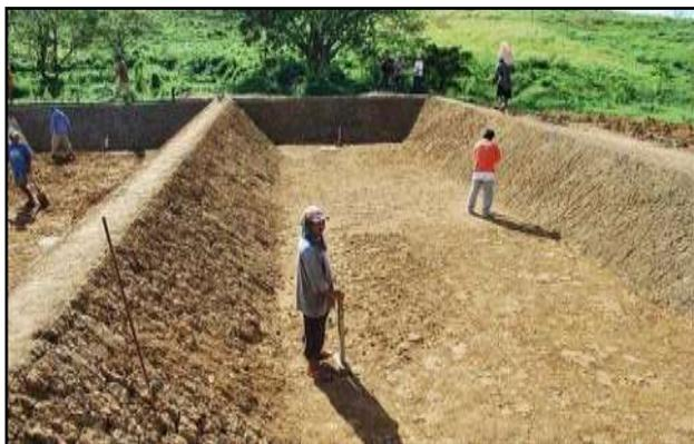
Figura 4. HA FSS en construcción en Bayawan, Filipinas, el humedal tratará el aguas residuales de un relleno sanitario (Fuente: J. Boorsma, 2009)
