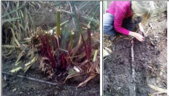
Figura 33 a/b La capa superficial de raíces puede obstruir las tuberías de distribución con raíces y humus (tratamiento de aguas negras en operación después de 2 años). (Fuente: H. Hoffmann, 2009)
