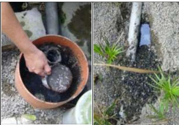
Figura 31. Trampa de grasa colapsada - el lodo obstruye la zona de infiltración, la cual se vuelve negra debido a la falta del transporte de oxígeno (obstrucción) (fuente: H. Hoffmann 2009)
